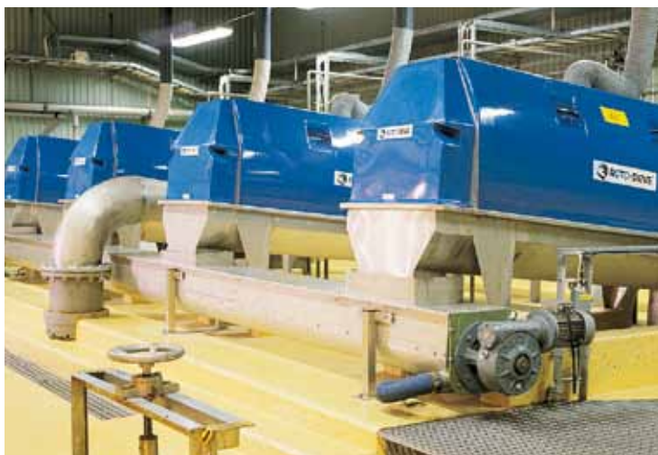
Installation de tamis rotatifs Roto-Sieve modèle RS 51 dans la station d'épuration Kullavik à Kungsbacka (Suède).
