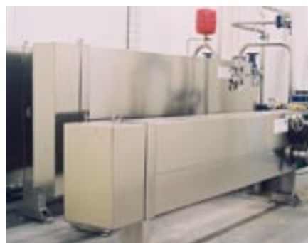
Echangeur thermique boues/eau Läckeby Products et unité d'échange thermique boues/boues installés à Älmhult.
