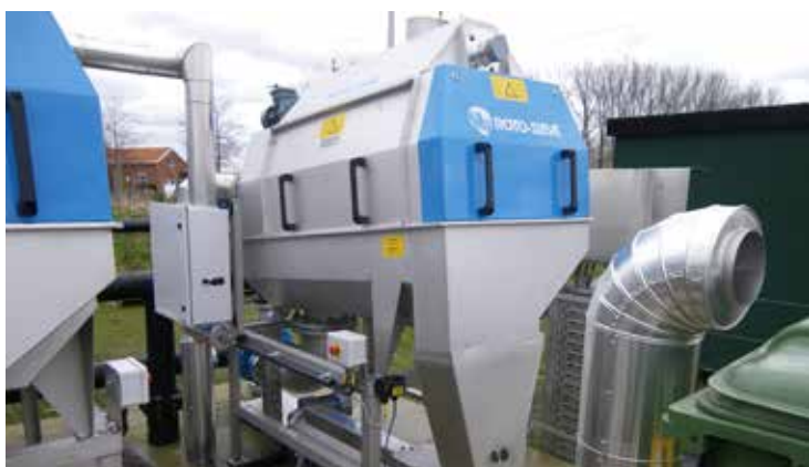
Installation av Roto-Sieve trumsilar modell RS-22 vid Zwalm reningsverk för skydd av membranläggningen.
