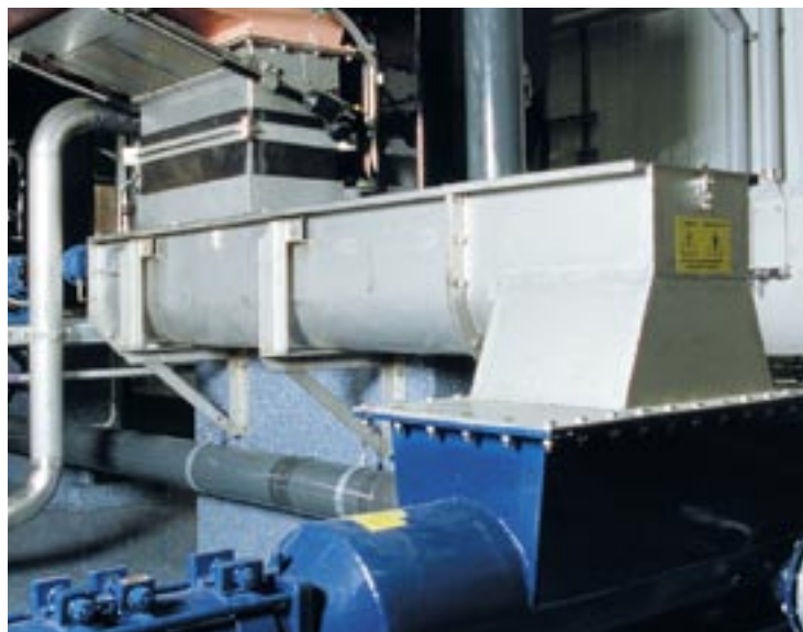
Transporteur à vis Läckeby Products destiné au transfert de boues épaissies entre centrifugeuse et pompe à boues.
